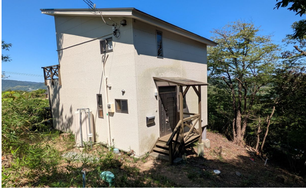
現況外観写真
