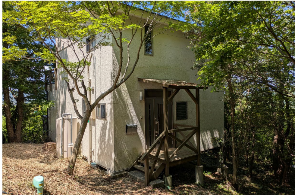
現況外観写真
