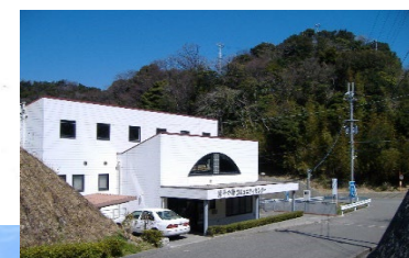
管理事務所 卓球場・シャワー室
